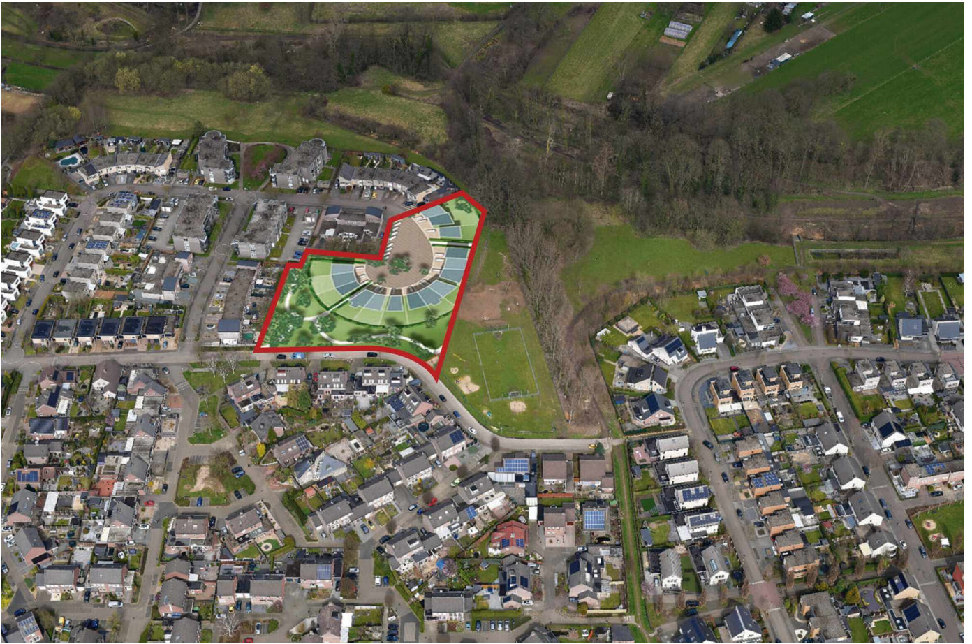
Het bouwproject Meerdel in Elsloo. © gemeente stein
