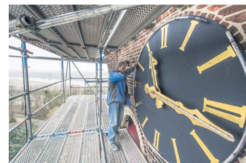
De kerktoren is de komende maanden het domein van bouwvakkers.
