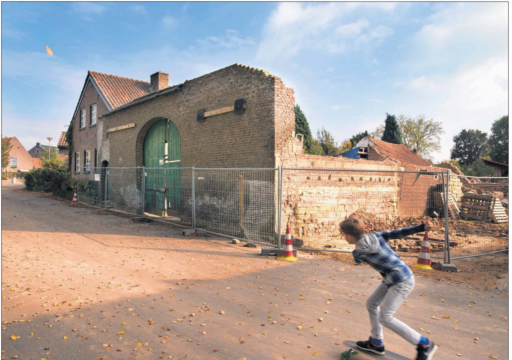
Achter de gestabiliseerde voorgevel van de boerderij staan nog resten van andere muren en ligt veel bouwpuin.
